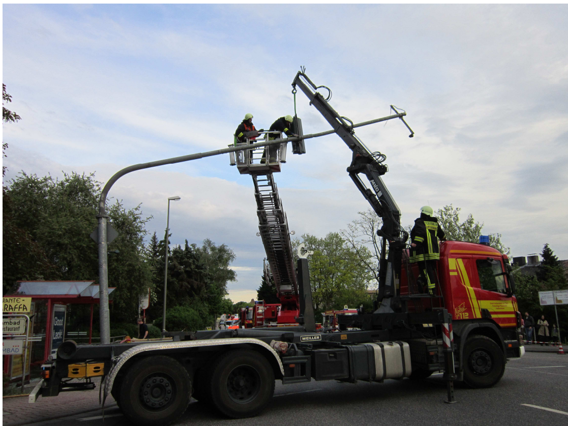
- Demontage der beschädigten Ampelanlage -
